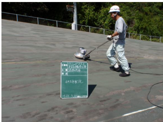
補修材塗布後 研掃
