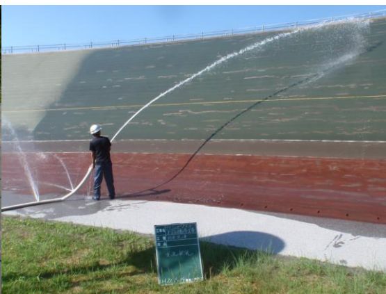
研掃後の洗浄状況
